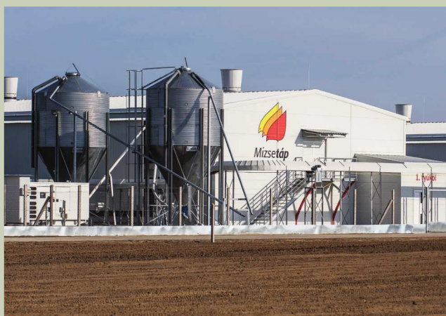
Az ultramodern Kinizsi telepi 1. sz. tojóház
